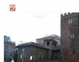
Roma, Casa di Dante al via i lavori di restauro
