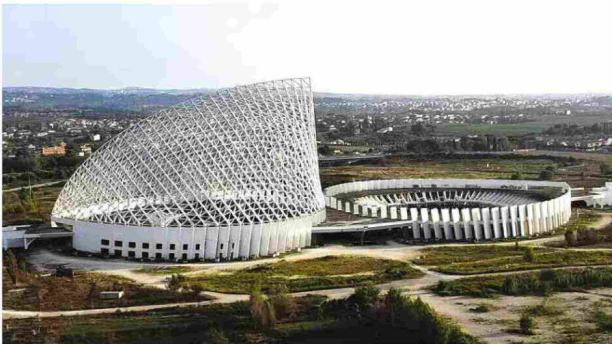
In alto, gli esterni dell'ex ospedale psichiatrico Santa Maria della Pietà, ora in fase di riqualificazione: il progetto del padiglione 5, che diventerà un centro polifunzionale per attività socio-assistenziali, culturali e di formazione, è stato affidato allo studio Settanta7 con Perillo srl (©Settanta7). Qui sopra, il sito della Città dello Sport di Santiago Calatrava, a Tor Vergata: la struttura, rimasta incompiuta per vent'anni, dovrebbe ospitare il Giubileo della Gioventù
