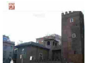
Roma, Casa di Dante al via i lavori di restauro
